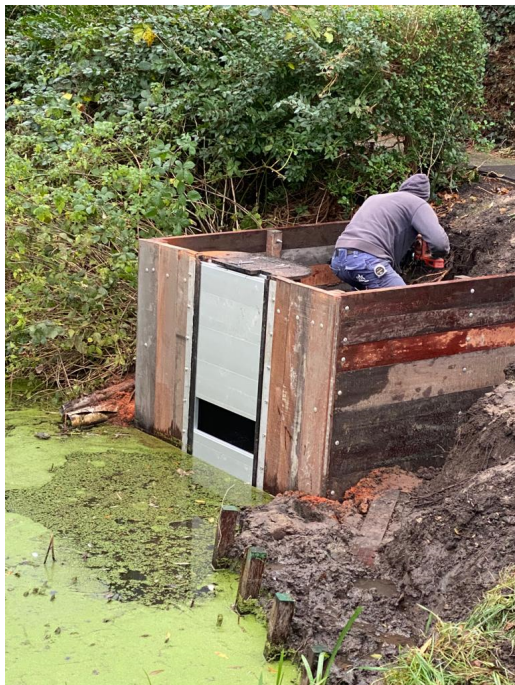
Figuur 2.4 Stuwput met verwijderbare schotten (links: aanleg, rechts: na oplevering)
