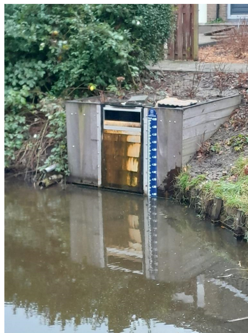
Figuur 2.4 Stuwput met verwijderbare schotten (links: aanleg, rechts: na oplevering)
